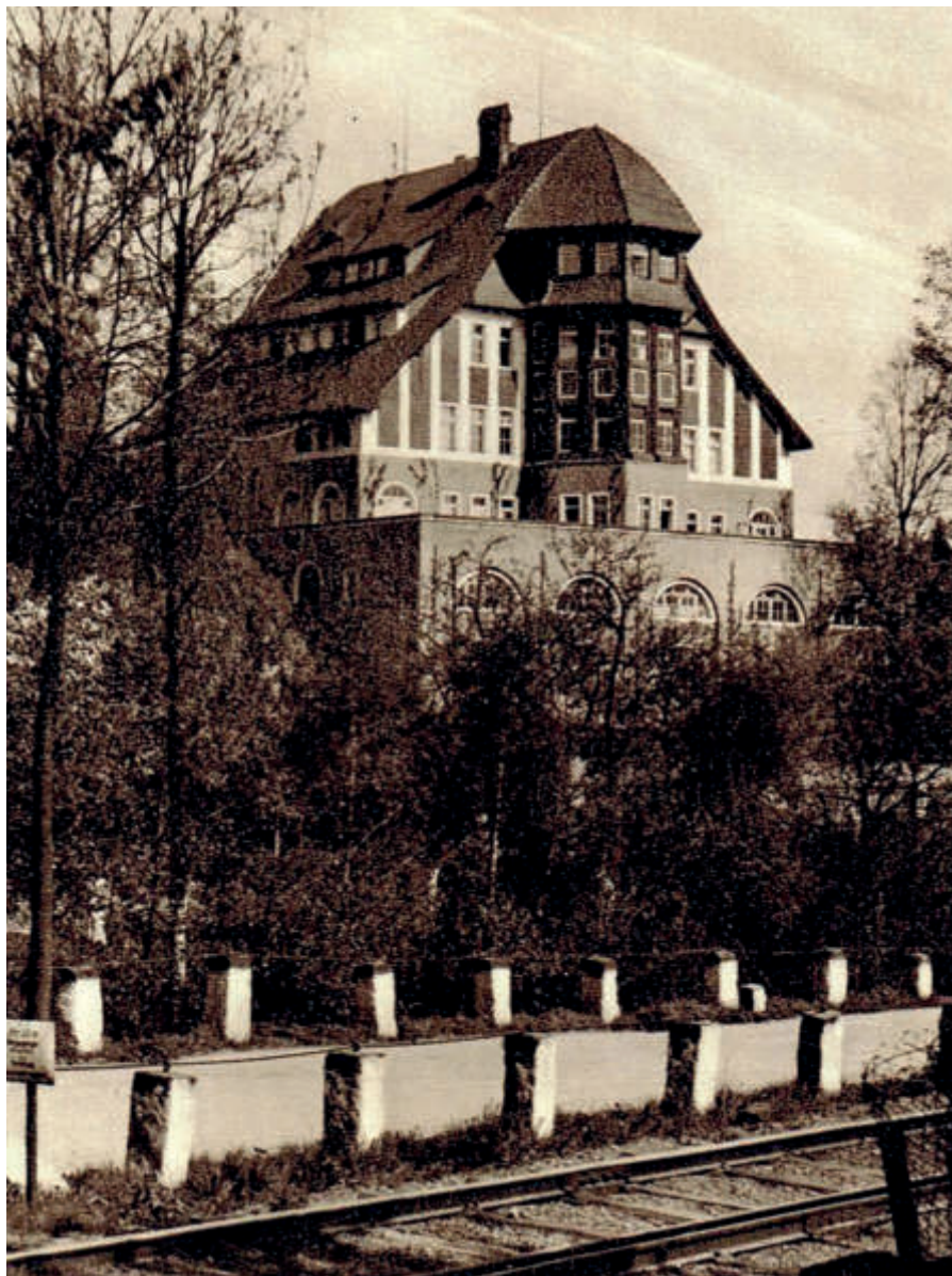
Das Boberhaus-Foto (ca. 1935 entstanden) zeigt die architektonische Schönheit des von Professor Hans Poelzig konzipierten Bauwerks, wie es einst beschaffen war. Deutlich zu erkennen ist auch heutzutage der aus Beton gefertigte Unterbau – seit ca. 11. Februar 1945 Ruine. Foto: Staatsarchiv Hirschberg
